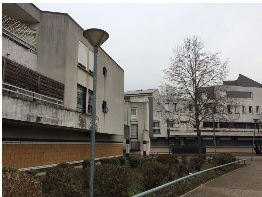
Nouveaux logements à taille humaine remplaçant la barre Debussy
