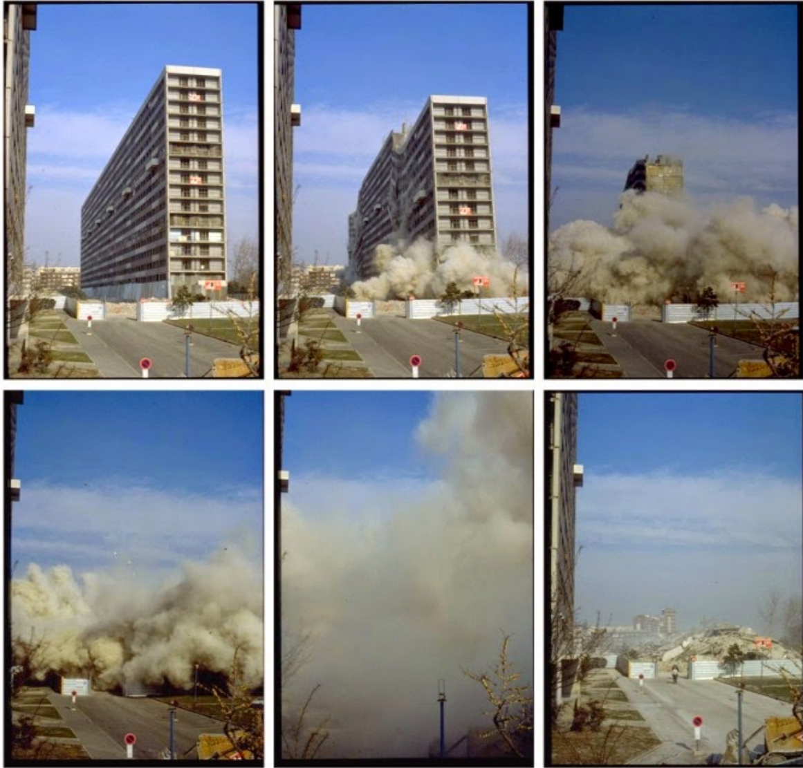
Destruction de la barre Debussy, 1986
